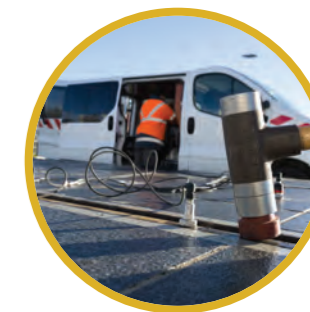
Réalisation de tests acoustiques
