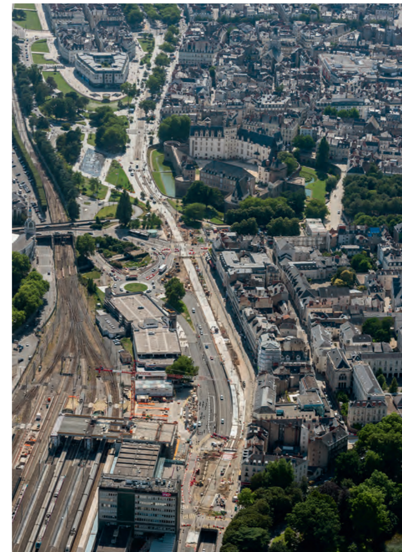
Vue aérienne de Nantes, ligne 1 du tramway, Gare Nord
